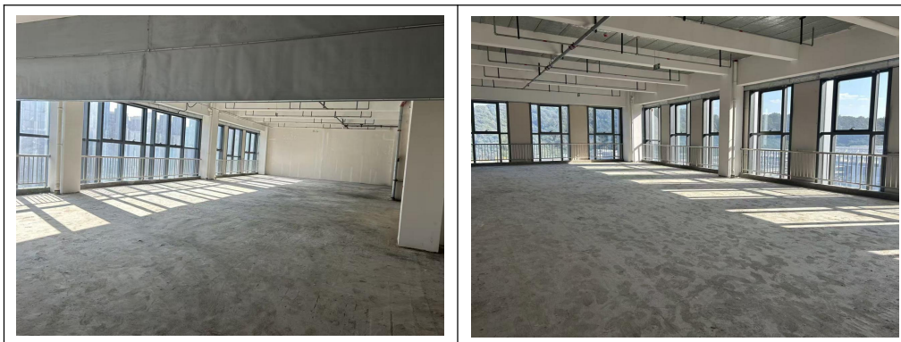
图 2-5 本项目拟建区域现状照片
